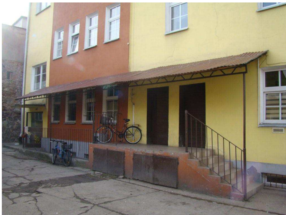
Widok budynku – od strony zaplecza i klatki K2
