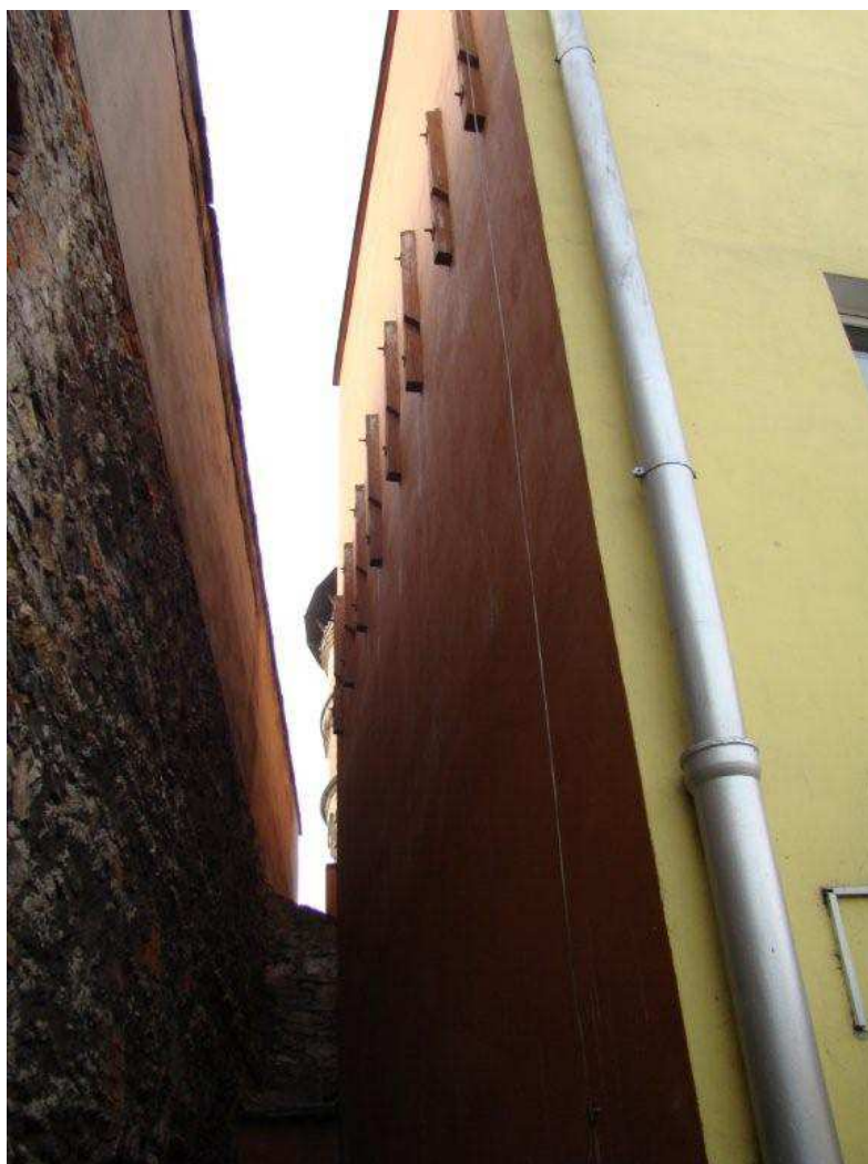
Widok ścian obu budynków – na wysokości piętra II /budowlane oddzielenie przeciwpożarowe/
